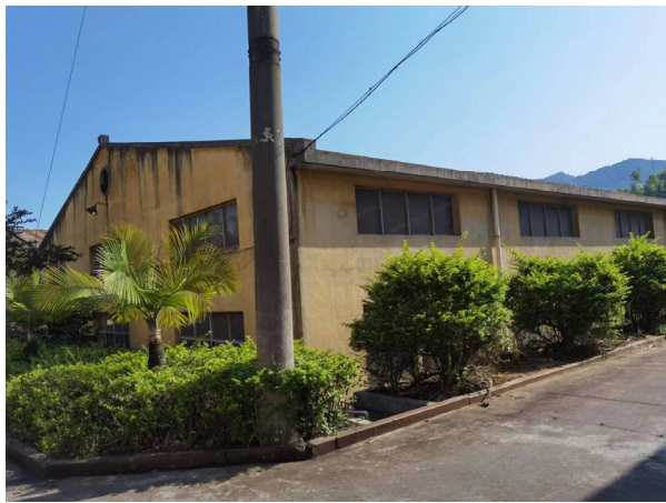
项目南侧-出租方厂房
