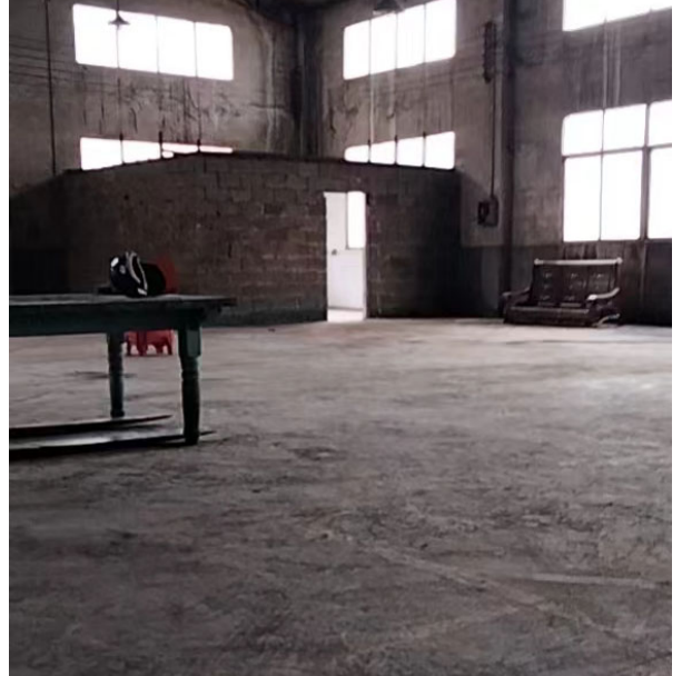
项目租用厂房现状-空厂房
