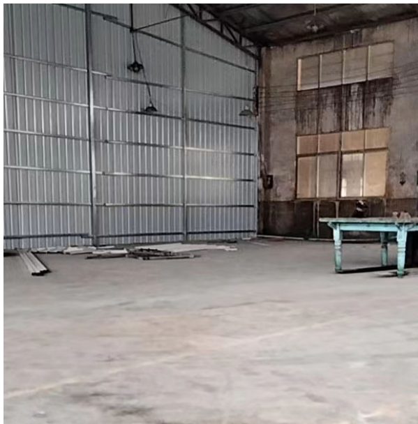
项目租用厂房现状-空厂房
